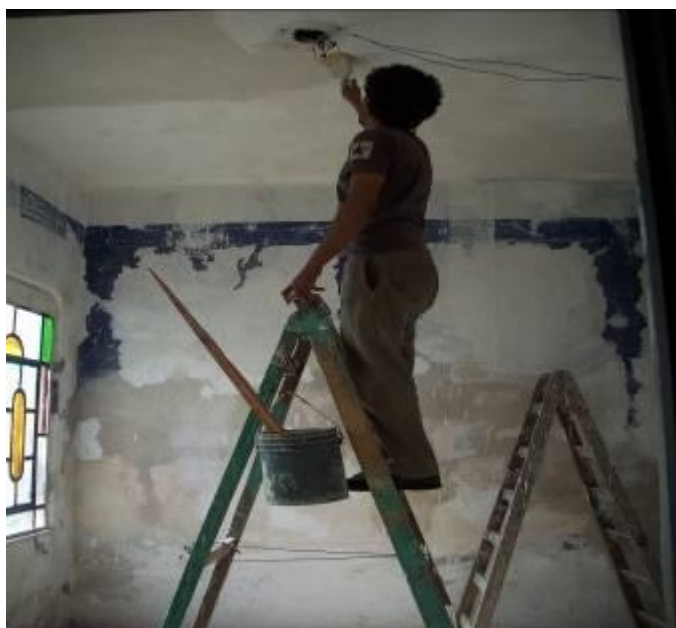
3) Continuamos con las jornadas de trabajo, acondicionando, reparando la casa.
